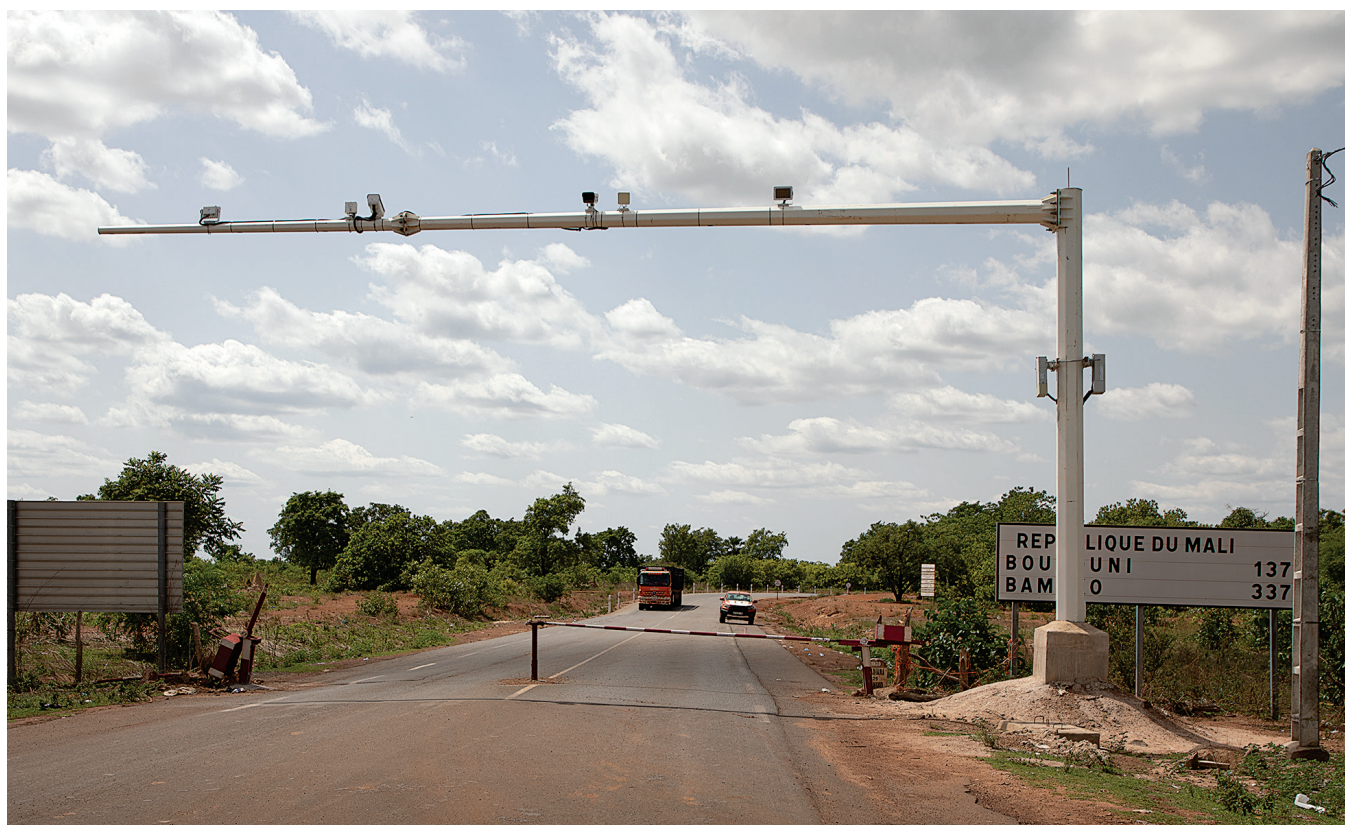
Poste Frontalière Côte d'Ivoire - Mali de Nigouni (département de Tengrela)
